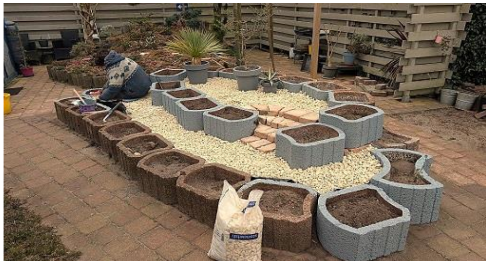
1. De Agave tuin in aanleg
